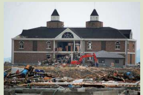
海と貝のミュージアムの被災状況
