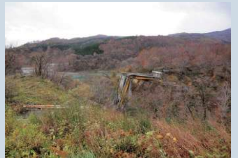
2008年岩手・宮城内陸地震の災害遺構祭時大橋
