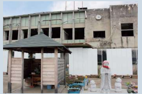
解体前の旧大槌町役場庁舎
